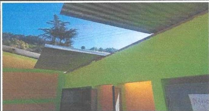
Foto 1: Se observa la falta de techo de los baños del módulo No. 3
