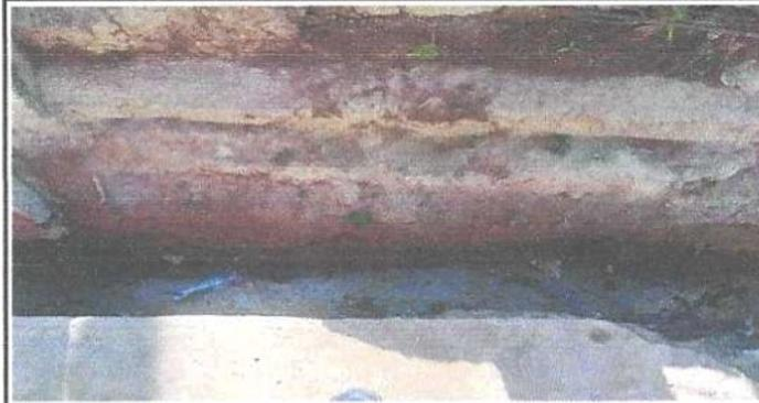
Foto 2: Se observa el deterioro de la cuneta del primer módulo.
