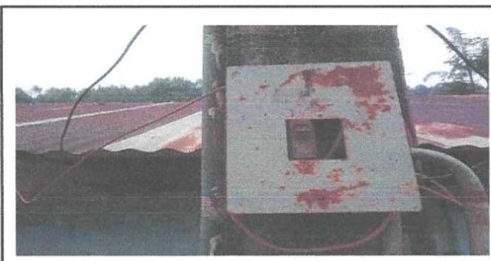
Foto 5: se observa el mal estado de la caja de flipones del módulo No. 2
