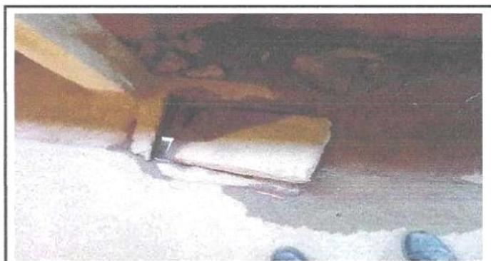
Foto 6: Se observa el mal estado de la caja de llave de paso del módulo No. 1.
