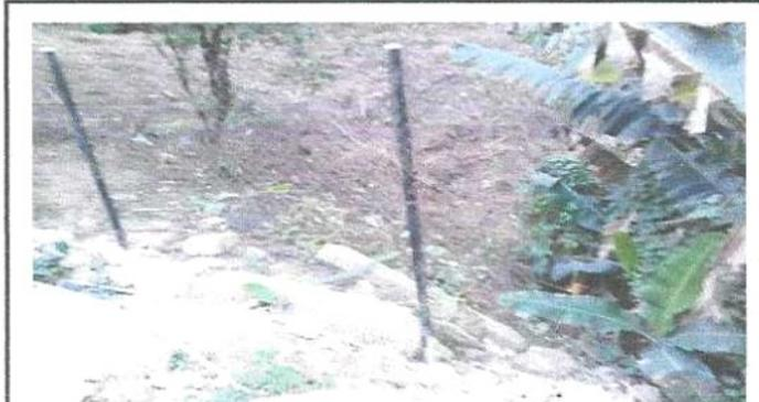
Foto 4: Se observa el mal estado de la malla de circulación del establecimiento.
